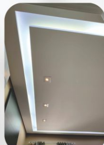
Sanca - Rasgo Iluminado
